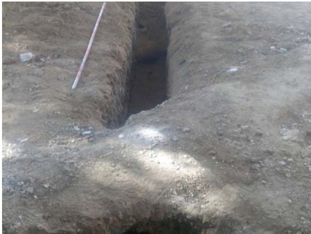
15. Vista d'un tram de la rasa 2.
