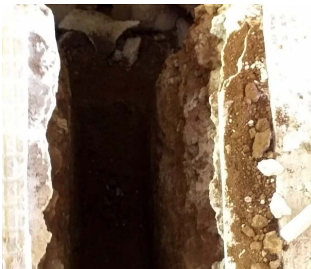
17. Vista d'un tram de la rasa 1.
