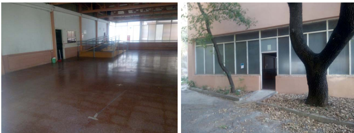
A l'esquerra vista de la sala polivalent, amb la rampa i la graderia al fons de la imatge. A la dreta, vista de la porta d'accés a la sala polivalent des del costat oest.
