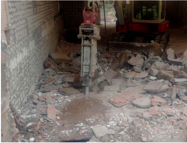
7. Vista del repicat del paviment (UE 02) de la cuina (sector A).
