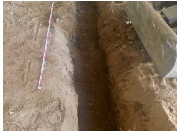
16. Vista d'un tram de la rasa 2.
