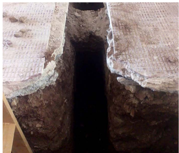
18. Vista d'un tram de la rasa 1.
