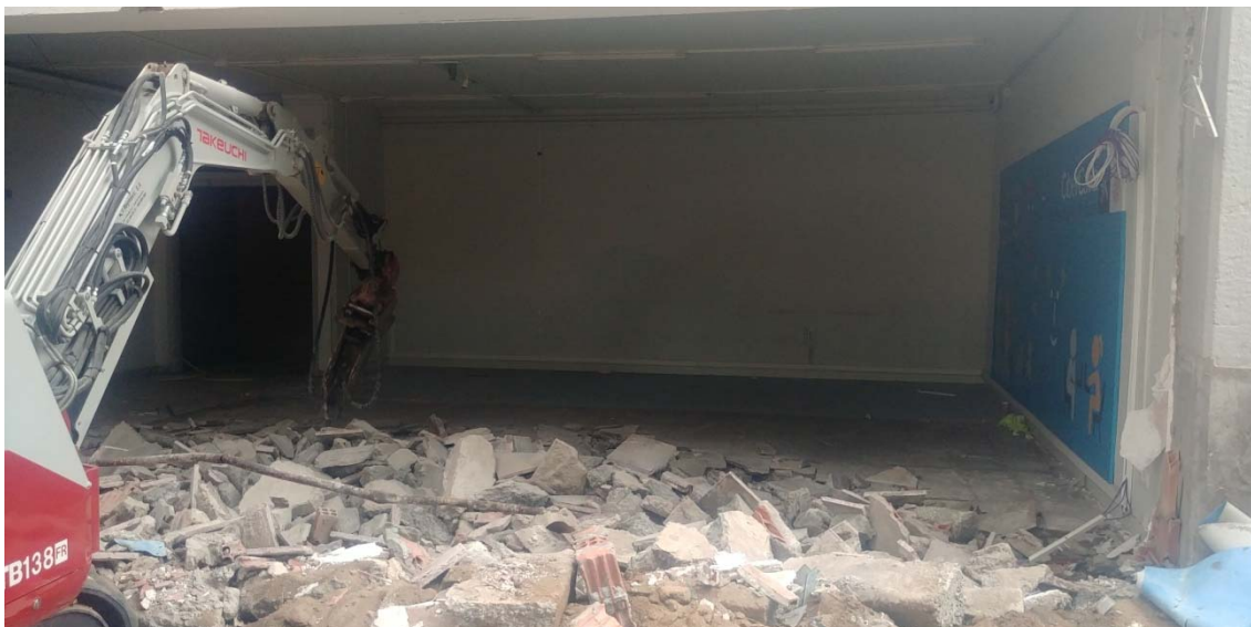
Vista dels treballs corresponents a l'eliminació del paviment existent en el sector B (UE 06).
