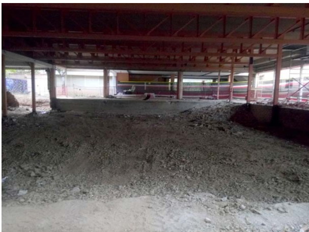
5. Vista general de la sala polivalent (sector A) una vegada finalitzats els treballs d'enderroc.
