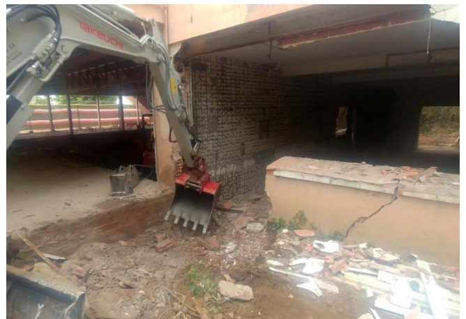
6. Vista del procés d'enderroc de la cuina (sector A).
