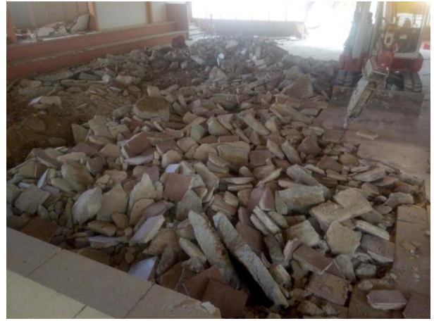
4. Paviment UE 02 repicat (sector A).
