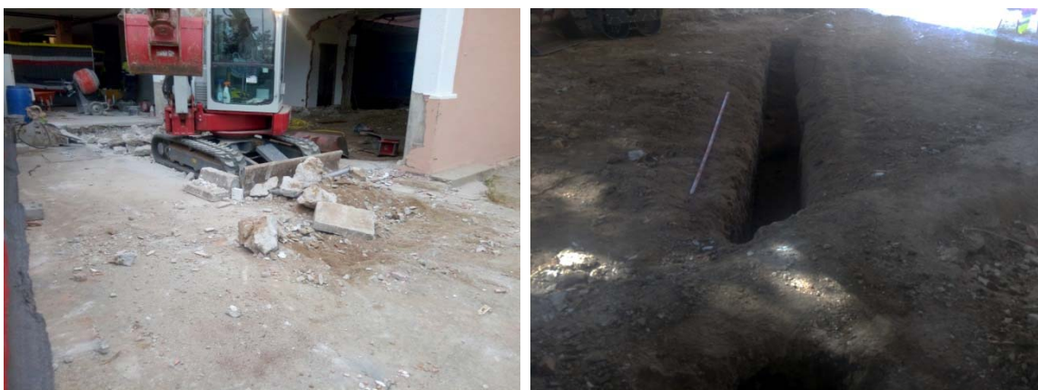
A l'esquerra vista dels treballs de retirada del paviment del sector B. A la dreta, vista d'un tram de la rasa 2.
