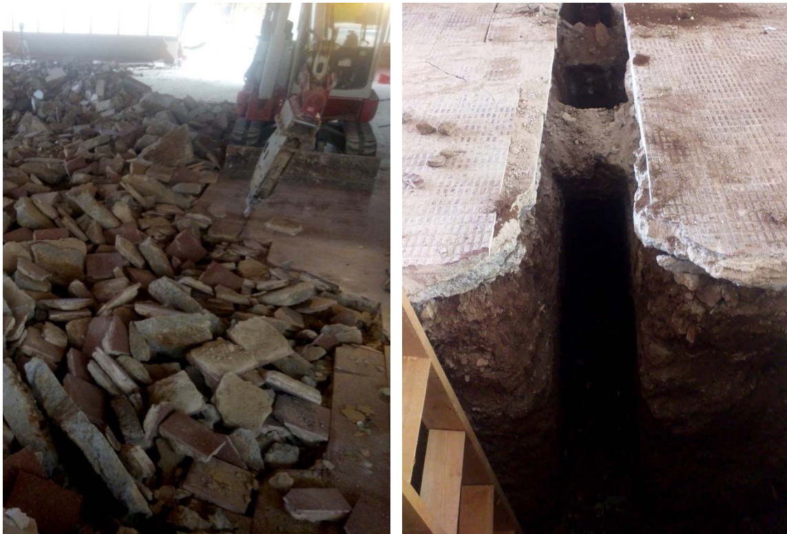
A l'esquerra, vista dels treballs de repicat i retirada del paviment del sector A. A la dreta, vista d'un tram de la rasa 1.
