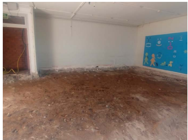
12. Vista de l'estrat UE 07 en una de les sales del sector B.
